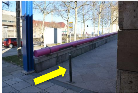
Blick auf die Rampe, die von der Konrad-Adenauer-Straße zum Eingang führt
